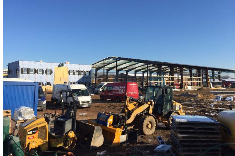
Halle der Dachbaustoffe Rath GmbH im Bau Foto: V. Künze
