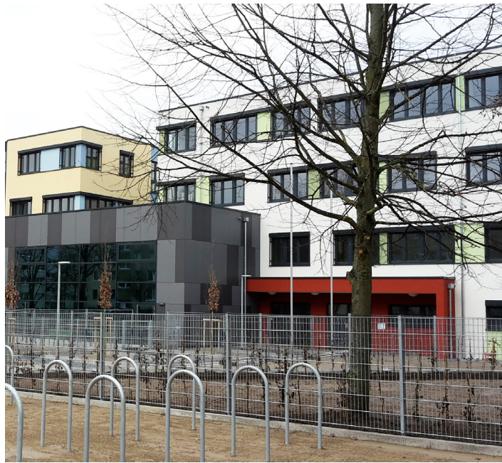
Nach den Winterferien wird der Schulbetrieb in dem Ersatzbau der John Brinckman Grundschule planmäßig starten. © ZGM
