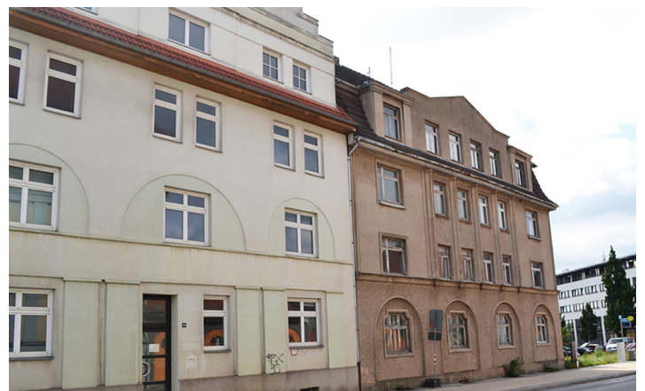
Nach dem Abriss der beiden Gebäude Werderstraße 66 und 68 wird an dieser Stelle der neue Heine-Hort gebaut, der bereits im laufenden Schuljahr 2017/2018 genutzt werden soll. © LHS
