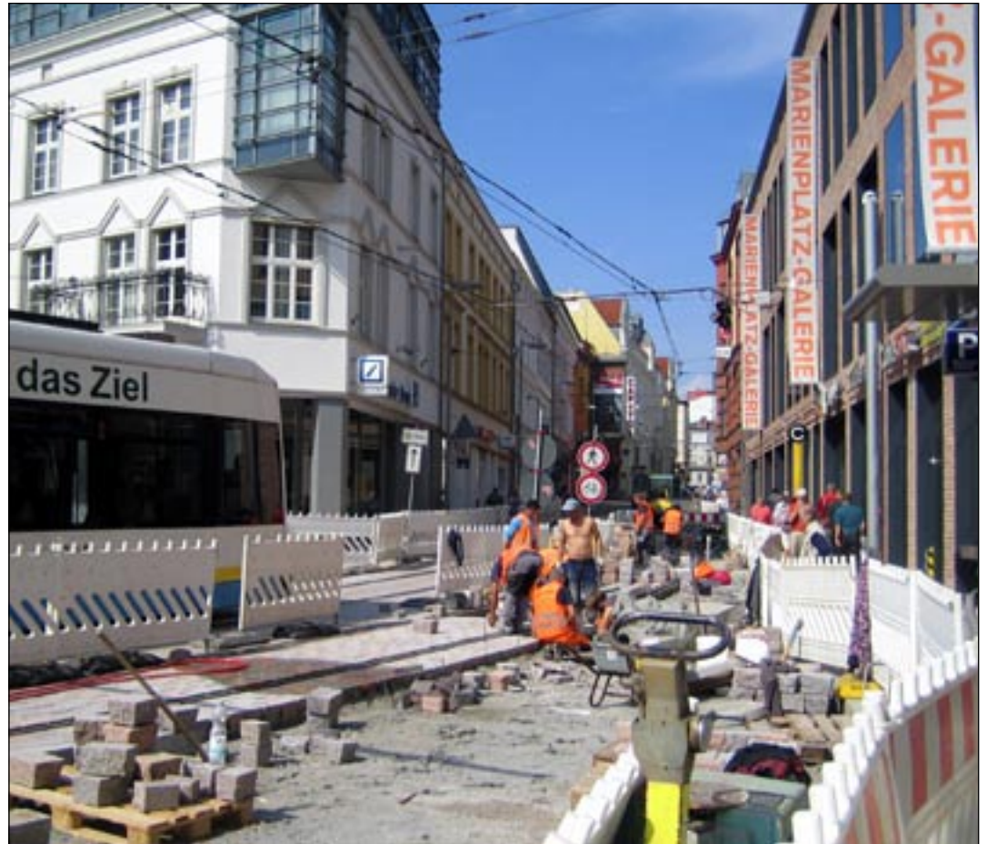
Die Pflasterkolonnen arbeiten sich in Richtung Wismarsche Straße vor. Ein Großteil der Verkehrsflächen und die Mittelinsel vor den Schweriner Höfen sind bereits fertig. Foto: Landeshauptstadt Schwerin
