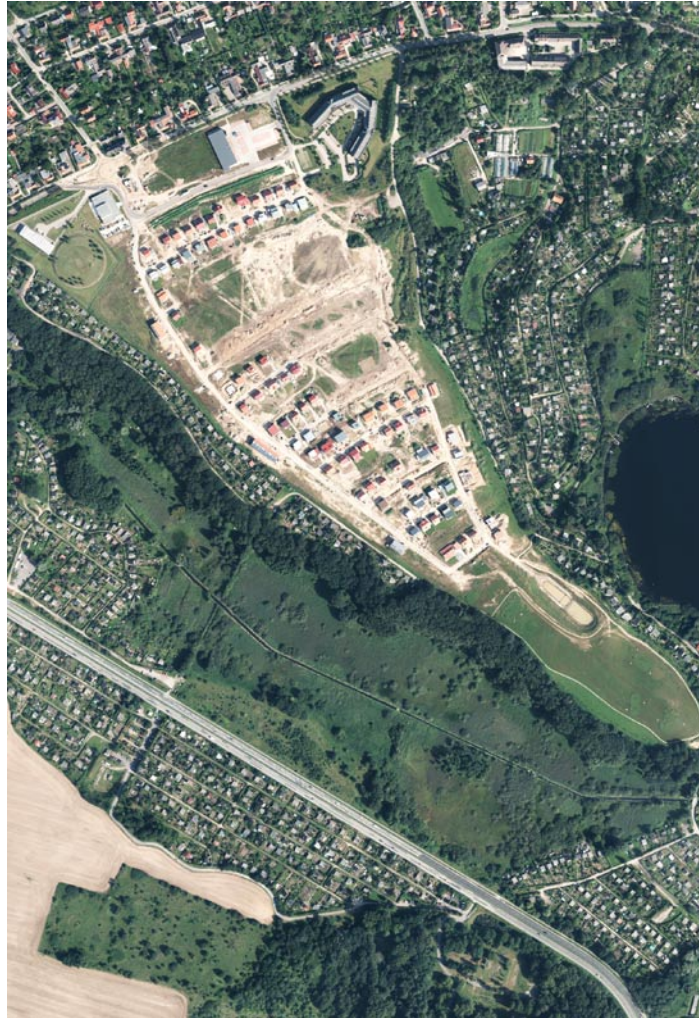
Blick auf das Baugelände Mühlenscharm
