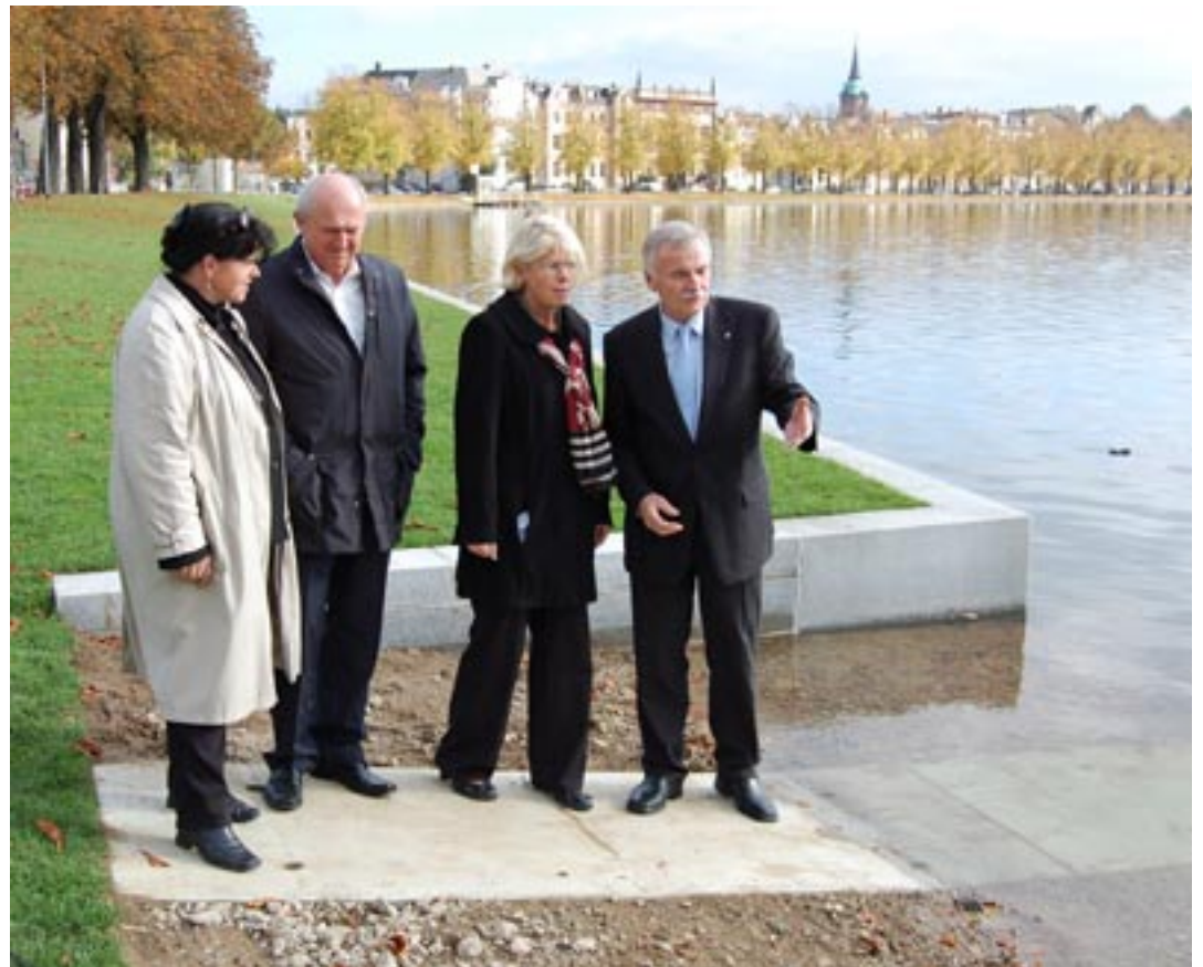
Wirtschaftsminister Jürgen Seidel (rechts) und Oberbürgermeisterin Angelika Gramkow (2.v.r.) begutachten gemeinsam mit Baudezernent Dr. Wolfram Friedersdorff und Marlies Bachmann von der SDS die fertig gestellte Uferbefestigung.
