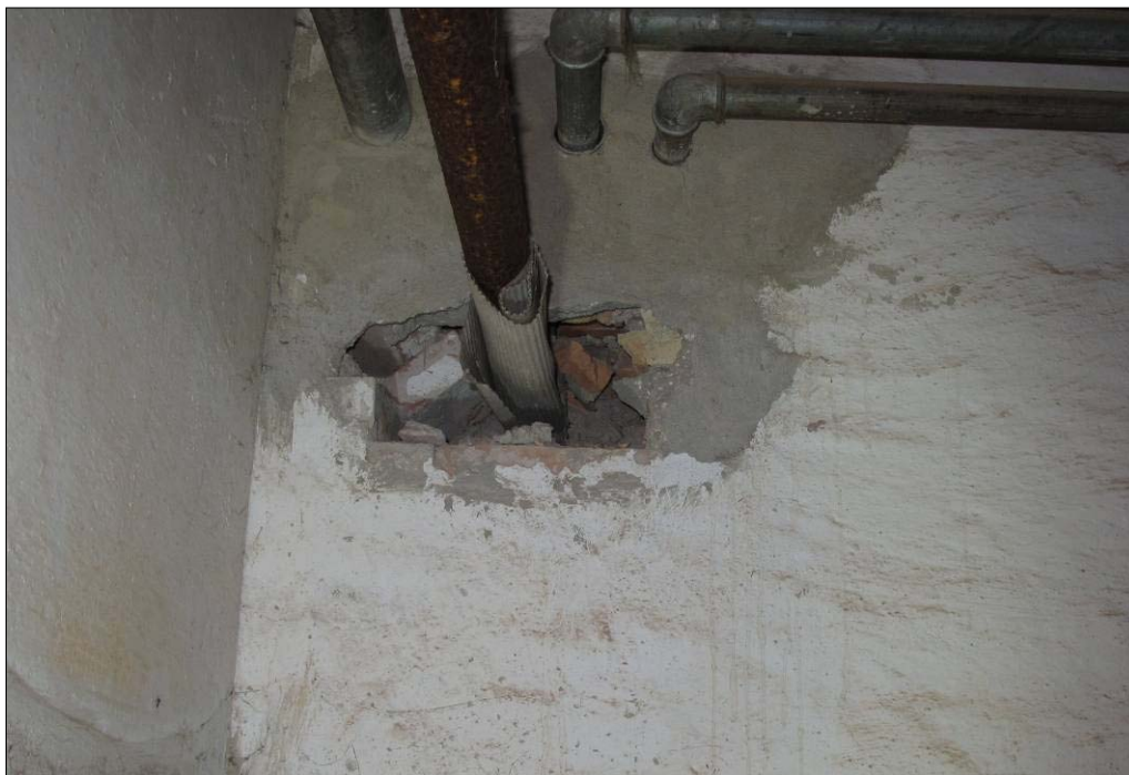
Abb. 3: Nicht vollständig vermauerter Wanddurchbruch im Kellergeschoss. Die "Schadstelle" ermöglicht überwinternden Fledermäusen sehr tief in das zerklüftete Mauerwerk vorzudringen. Derart tief "sitzende" Tiere sind auch mit dem Endoskop kaum sichtbar zu machen.
