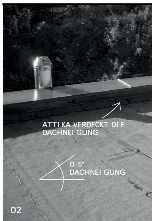
Prinzip verdeckte Dachneigung durch Attika bei einer zweigeschossigen Bebauung
