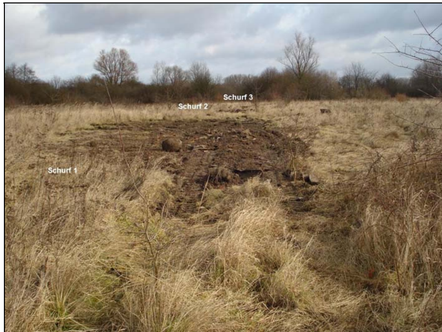
Bild 11 : Verfüllen /Planierarbeiten Schurfe 1-3
